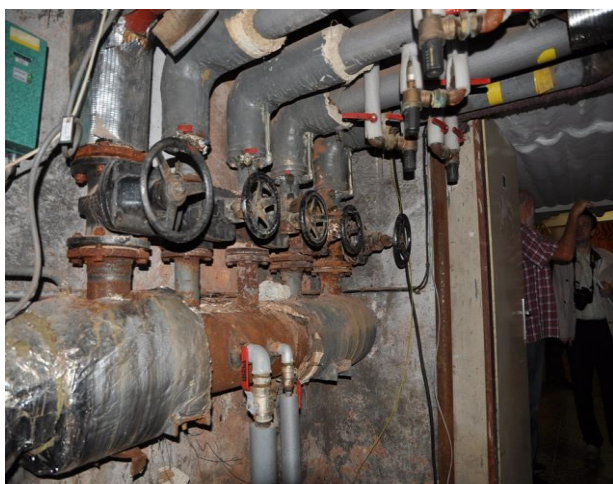
Hlavní rozdělovač a sběrač Rozdělovač a sběrač v budově B
