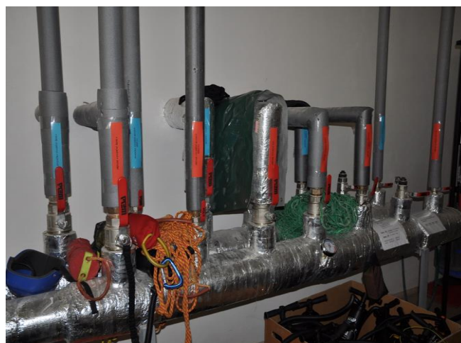
Hlavní rozdělovač a sběrač Rozdělovač a sběrač v budově B
